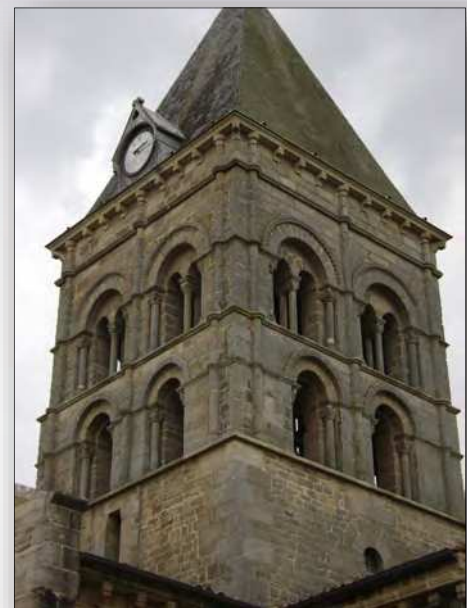
Le clocher de Varenne-l'Arconce (© Claire Dépalle)
