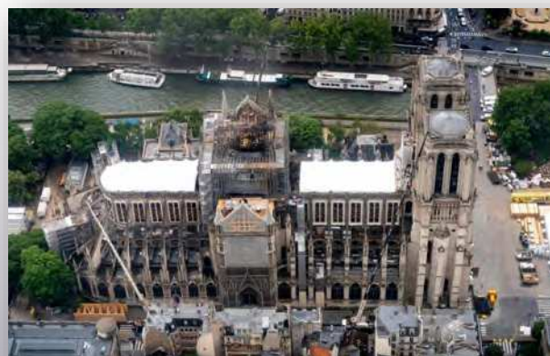
Le chantier de Notre-Dame de Paris, aujourd'hui (© Google images)
